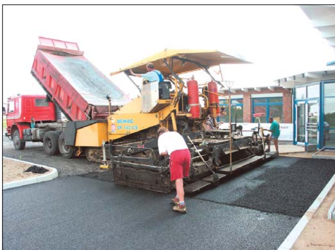
Abb.8: Einbau der Deckschicht mit Asphaltfertiger
