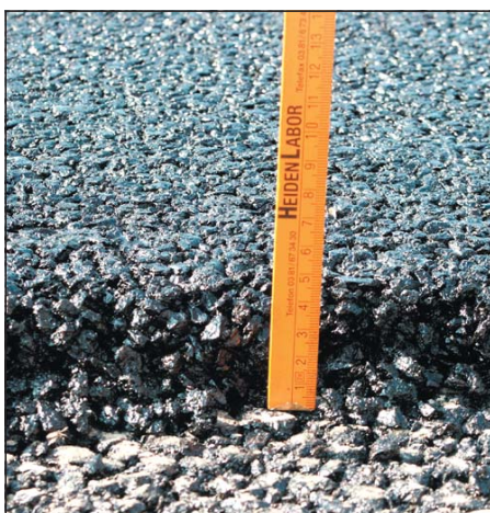
Abb. 10: Detail der 3 cm dicken WDA-Deckschicht 0/8
