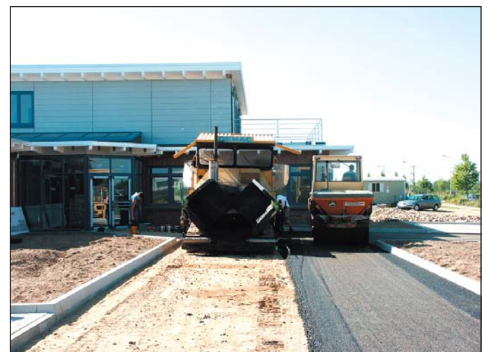
Abb. 9: Einbau der 9 cm dicken WDA-Tragschicht 0/16 sowie Verdichtung mit statischer Walze
