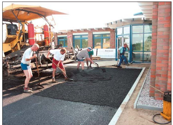
Abb.7: Leichter Einbau der Deckschicht 0/8 mit Hand, positive Wirkung des Asphaltverflüssigers
